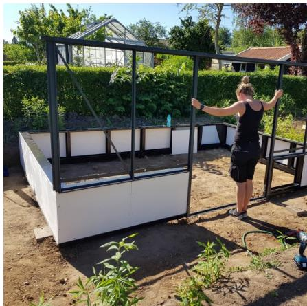
Kasvihuoneen kasatut seinäkehikot nostetaan moduulisokkelin päälle ja asennetaan kiinni toisiinsa.
