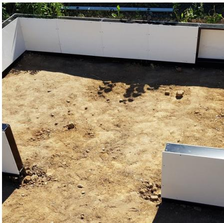
Fiberementskivorna skruvas fast på inre och yttre delarna av modulsockeln. Skivorna är miljövänliga och avstöter mögel, insekter, skadedyr etc. Dessutom tål de en hel olika kemikalier.
