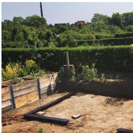
Sokkeliraami asennetaan paikoilleen tasaiselle pohjalle ja ankkuroidaan maaperään.
